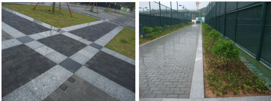
图 F4-5 透水铺装地面和下沉式绿地实景图
