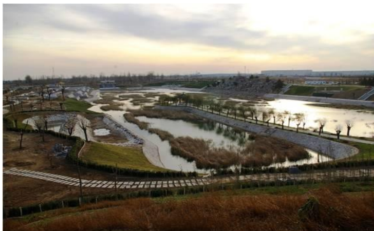
图 F4-17 多功能调蓄水体公园实景
